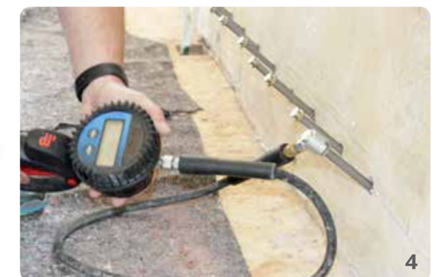
Die Abbildungen 1-4 zeigen den Ablauf der Erstellung einer nachträglichen Horizontalsperre mit BKM-HZ250 Pro durch den zertifizierten Fachbetrieb.
